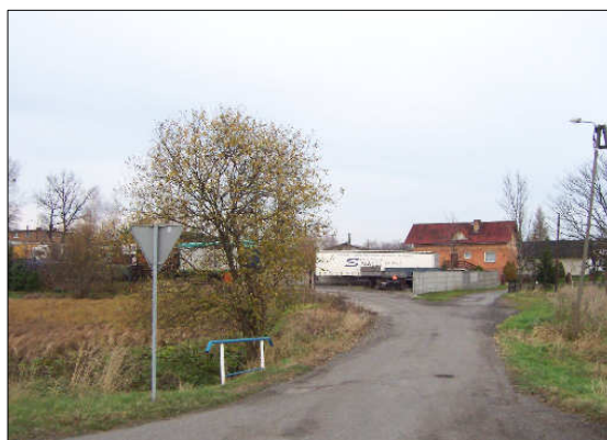
Ulica Damrota - widok od strony ulicy Mikołowskiej
