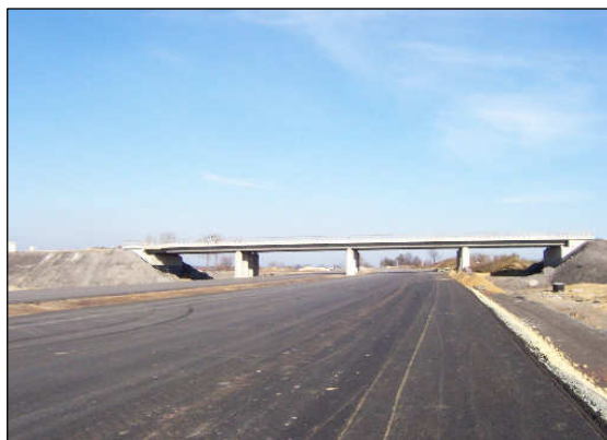
Budowa autostrady A1 – węzeł Dębieńsko
