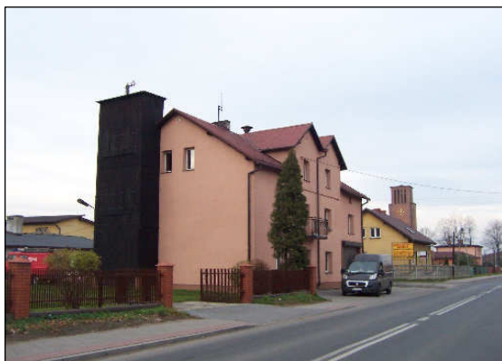
Budynek Ochotniczej Straży Pożarnej przy ulicy Ks.A.Pojdy
