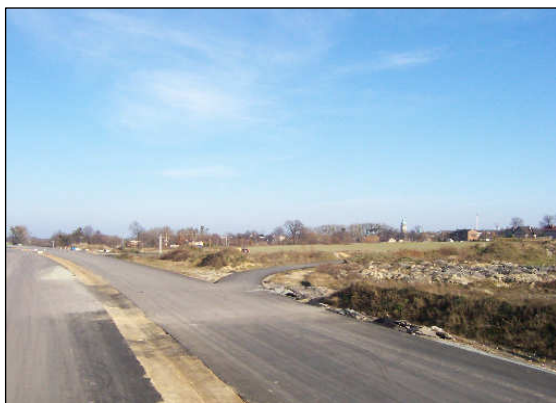
Budowa autostrady A1 – węzeł Dębieńsko
