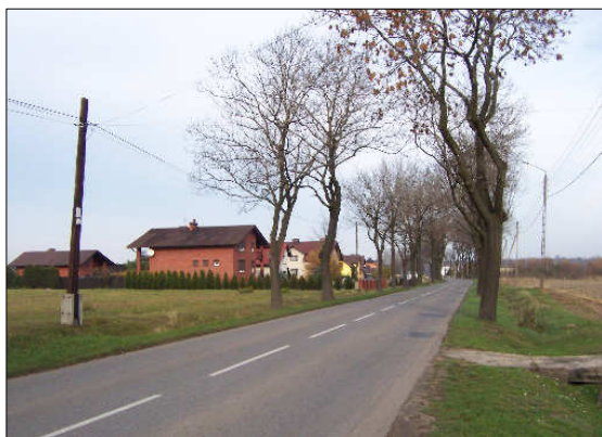
Zabudowa przy ulicy Gliwickiej
