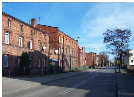
Ulica Furgota – widok w kierunku Dębieńska
