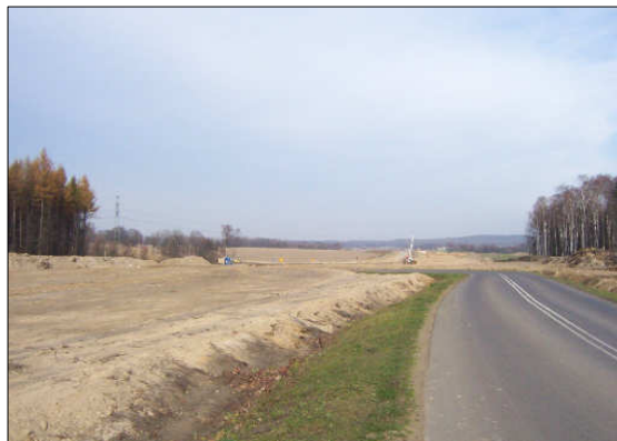
Ulica Żorska – budowa autostrady A1
