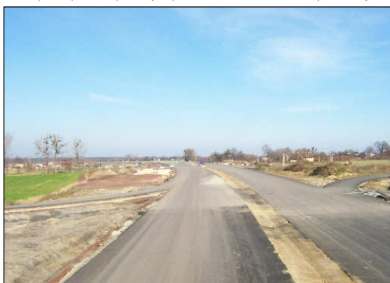
Budowa autostrady A1 – węzeł Dębieńsko
