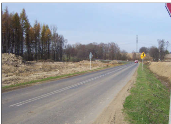
Ulica Żorska – budowa autostrady A1
