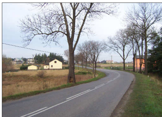
Dojazd do Szczekowic ulicą Gliwicką od strony Żor
