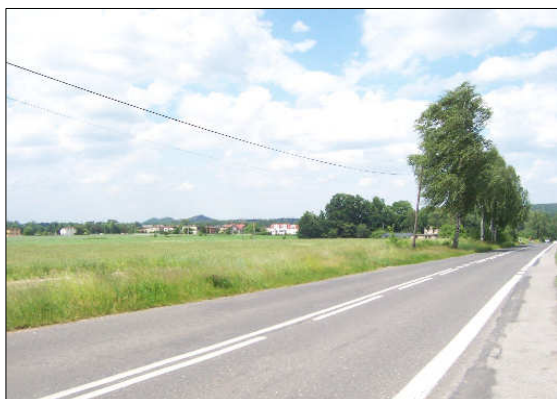
Ulica Palowicka – widok w kierunku centrum sołectwa
