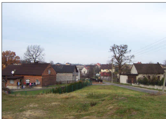
Widok zabudowy przy ulicy Rybnickiej
