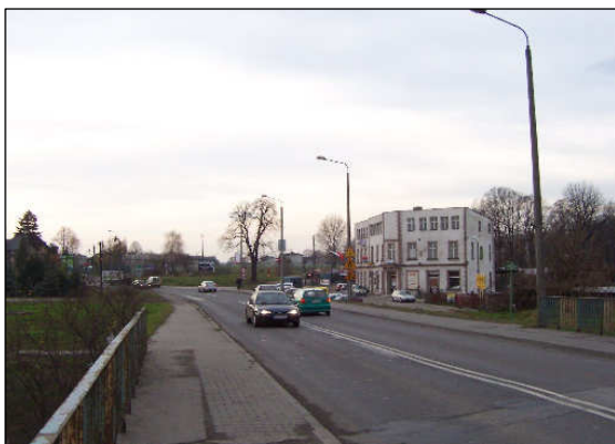
Ulica Furgoła w rejonie mostu na rzece Bierawka
