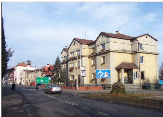
Budynek Urzędu Miasta przy ulicy Parkowej
