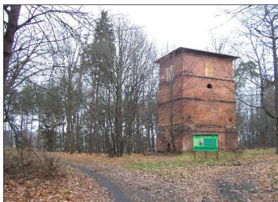
„Gichta” – wieża wsadu piecowego dawnej huty „Waleska”
