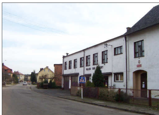
Budynek Domu Kultury i Straży Pożarnej przy ulicy Rybnickiej
