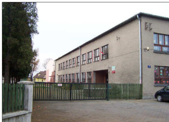
Szkoła Podstawowa w Stanowicach
