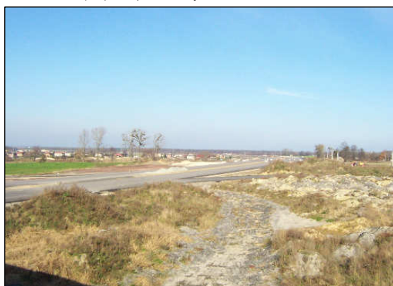
Budowa autostrady A1 – węzeł Dębieńsko
