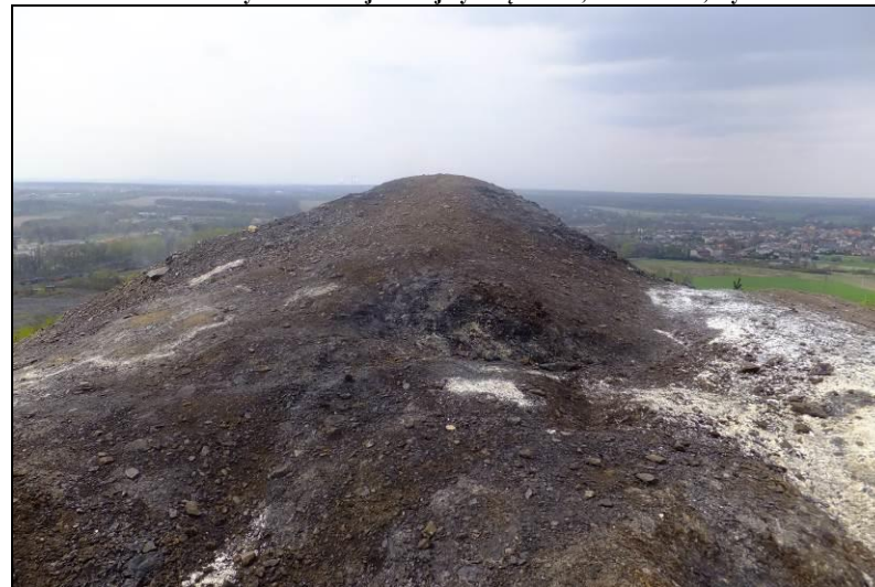
Fot. 16 Palący się wierzchołek haldy nr 2, biały nalot to prawdopodobnie różnego typu siarczany, efekt utleniania minerałów siarczkowych w wysokich temperaturach
