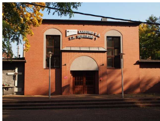
Budynek Cechowni KWK „Dębieńsko” przy ul. 3 Maja
