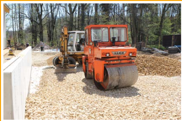
Budowa sali gimnastycznej przy Szkole Podstawowej w Palowicach
