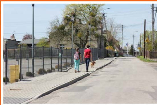
Częściowy remont ul. Szkolnej w Stanowicach
