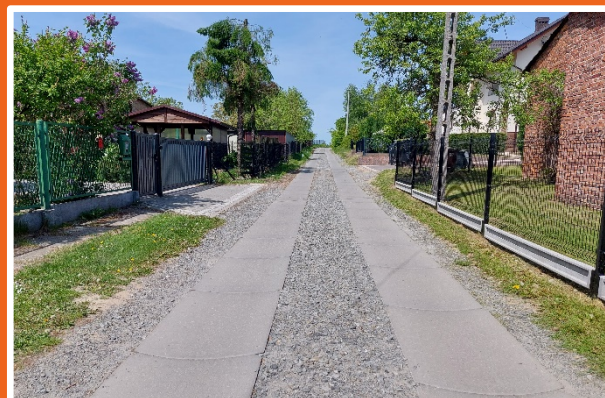
Wyremontowana ul. Szkolna w Przegędzy
