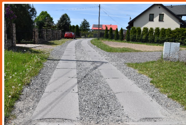
Wyremontowana ul. Gospodarcza w Stanowicach
