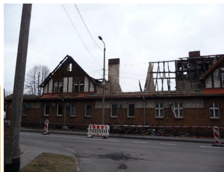
Remont generalny budynku przy ul. Wolności po pożarze w lutym 2020r.
