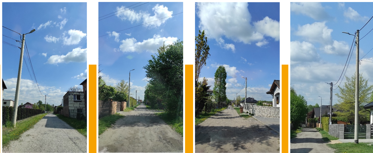
oświetlenie przy ul. Ks. Pojdy w Książenicach
