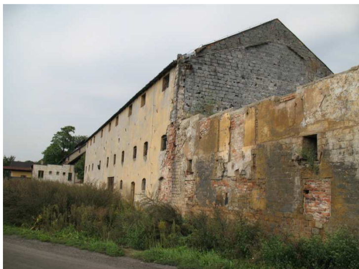
Niszczące budynki pogarszające walory krajobrazowe opracowania
