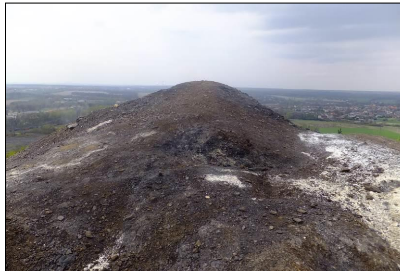
Fot. 7 Palący się wierzchołek hałdy nr 2, biały nalot to prawdopodobnie różnego typu siarczany, efekt utleniania minerałów siarczkowych w wysokich temperaturach
