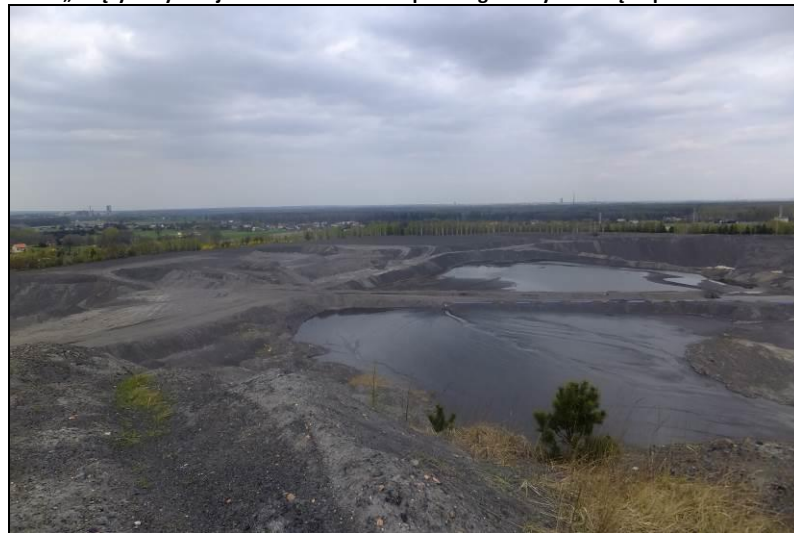
Fot. 4 Osadniki mułowe na terenie składowiska
