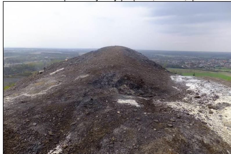
Fot. 16 Pałący się wierzchołek haldy nr 2, biały nalot to prawdopodobnie różnego typu siarczany, efekt utleniania minerałów siarczkowych w wysokich temperaturach
