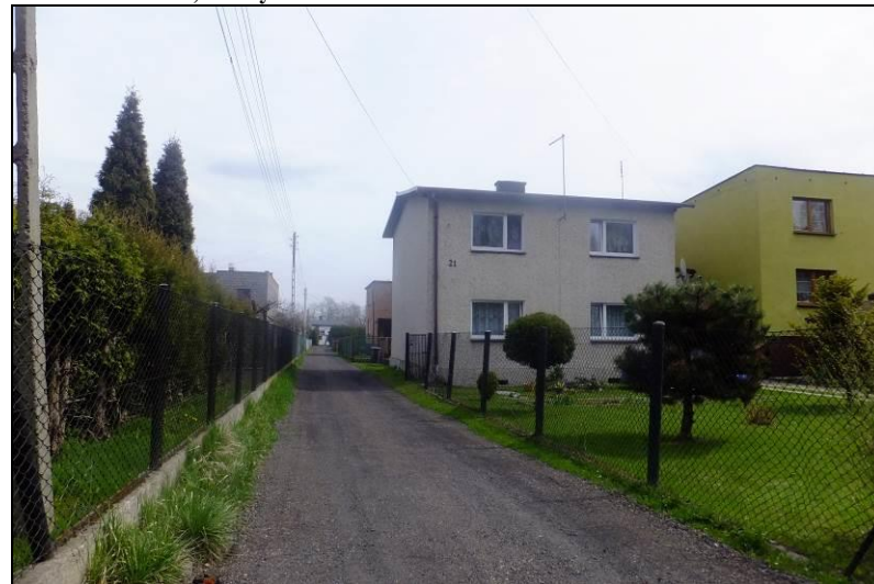
Fot. 20 Teren nr 7, zabudowa przy ul. Cmentarnej
