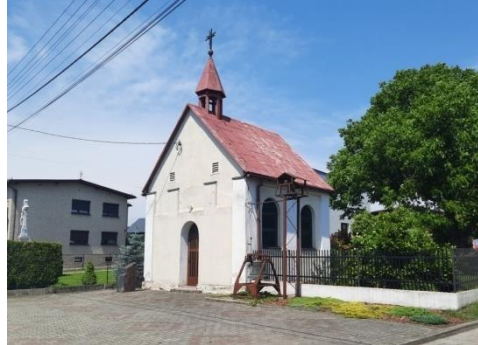
Fot. 79 Kaplica Szczekowicach ul. Rybnicka
