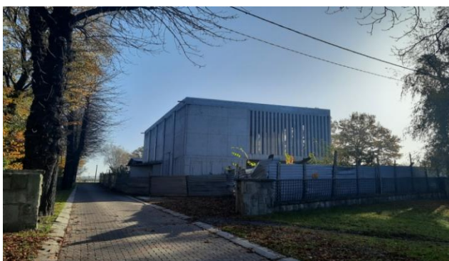
Fot. 70 Widok w kierunku zachodu – budowa
