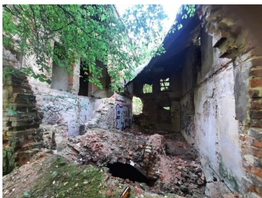
Fot.47 Nowy Dwór 3, ruina dworu.
