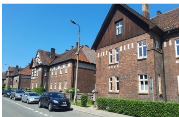
Fot. 21 Zabudowa ulicy Kombatantów
