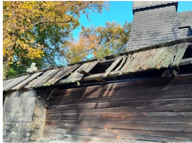
Fot. 33,34 Kamienne ogrodzenie kościoła wymagające pilnych prac zabezpieczających
