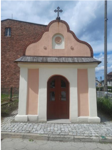
Fot.77 Kaplica w Leszczynach ul. Pojdy/Czereśniowa
