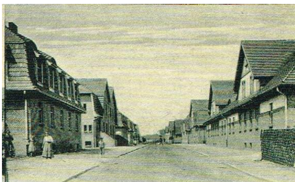
Fot.19 Zabudowa ulicy Hallera - pocztówka
