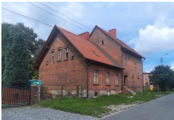
Fot. 80 Dawna szkoła w Palowicach ul. Szkolna
