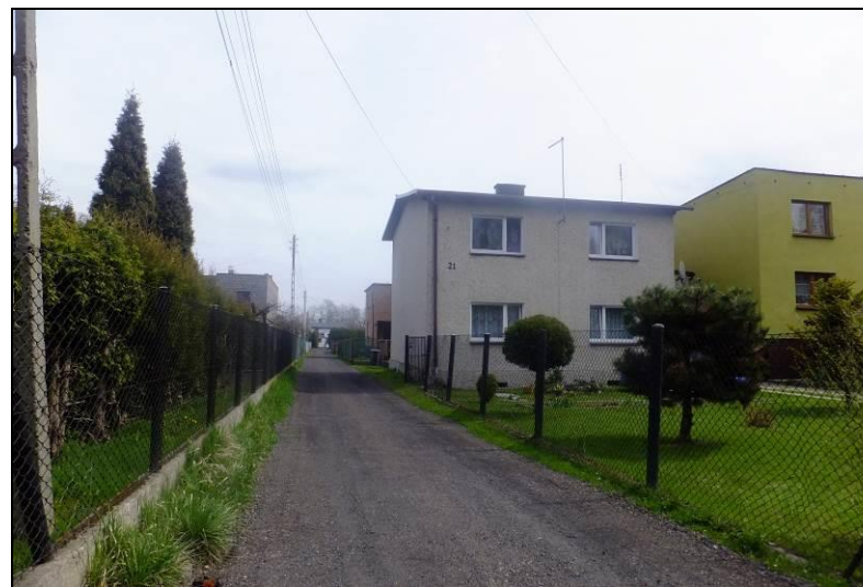
Fot. 11 Teren nr 7, zabudowa przy ul. Cmentarnej
