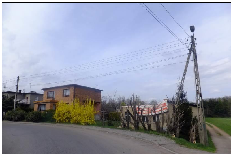
Fot. 9 Teren nr 6, ul. Szyb Zachodni
