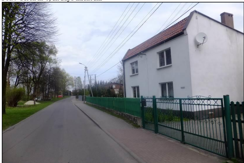
Fot. 10 Teren nr 6, ul. Szyb Zachodni
