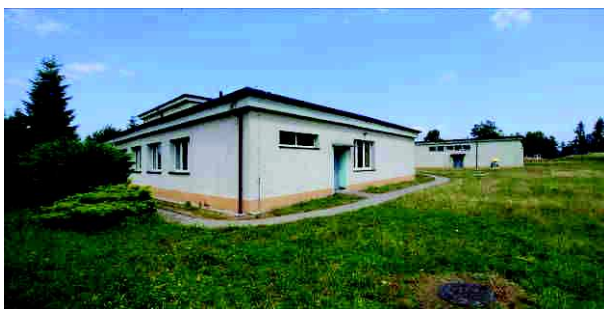
Fot. 1. Widok segmentu od strony rozbudowy
