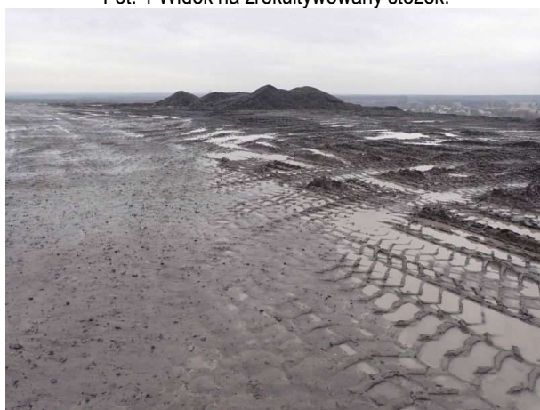
Fot. 3 Widok na teren zwałowiska.
