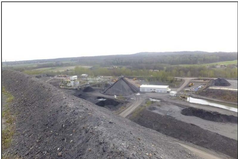
Fot. 5 Widok ze składowiska w kierunku wschodnim, na drugim planie widoczna Ramża
