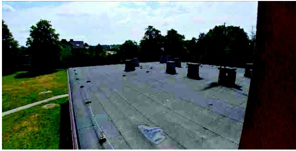
Fot. 3. Dach w części adaptowanej
