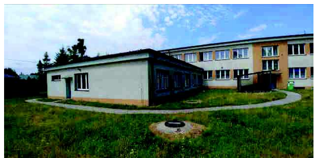
Fot. 2. Widok segmentu od strony rozbudowy
