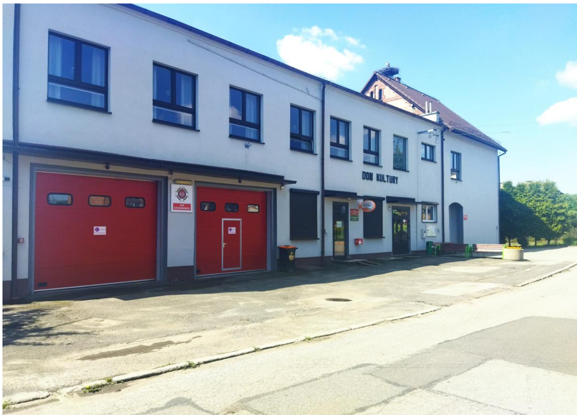
Ochotnicza Straż Pożarna i Wiejski Domu Kultury w Szczekowicach
