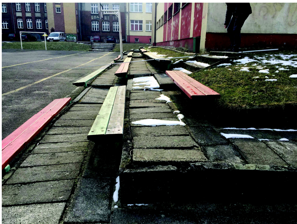
Fot. 4 Widok na istniejące trybuny terenowe
