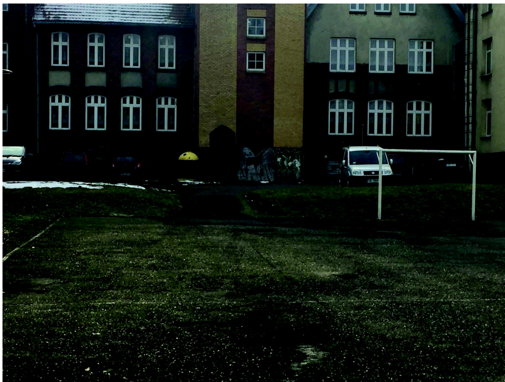
Fot. 3 Widok na teren dojścia do istniejącego boiska
