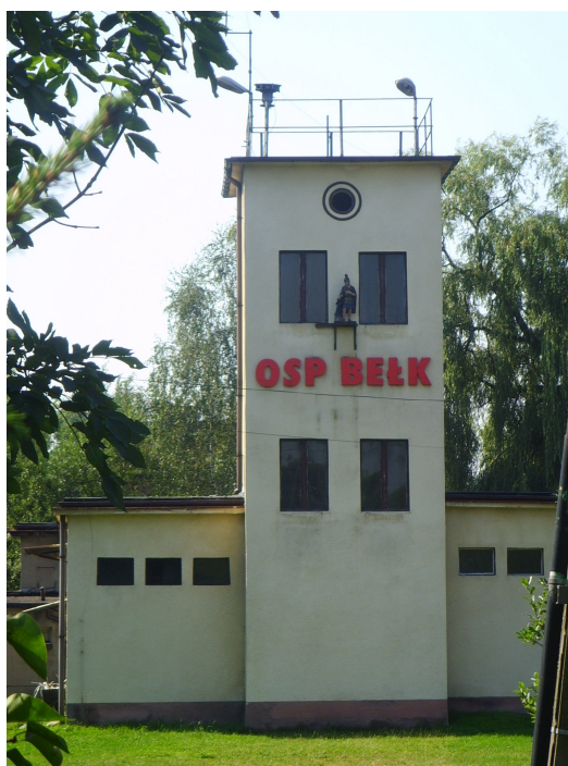
Budynek Ochotniczej Straży Pożarnej w Belku
