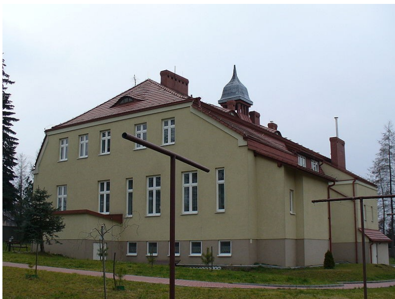
Dawny szpital z 1908 r. – widok obecny po remoncie
