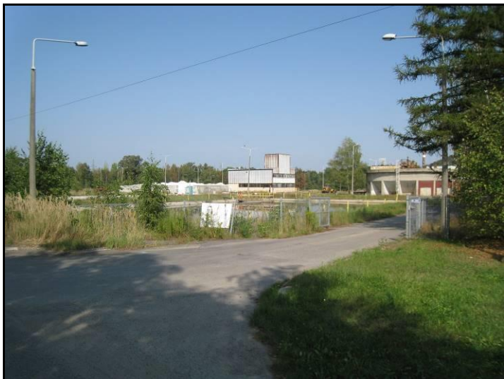
Fot. 9 Oczyszczalnia ścieków, widok w części północnej
