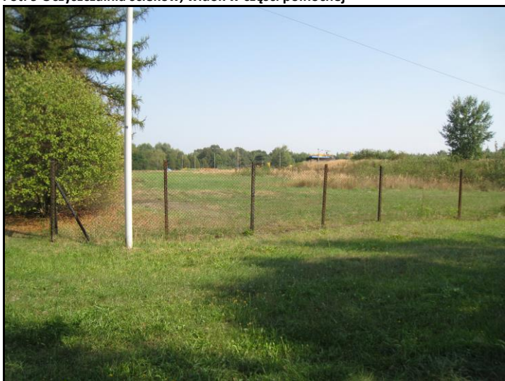
Fot. 10 Oczyszczalnia ścieków, część centralna
