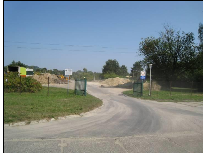
Fot. 4 Południowa część oczyszczalni ścieków
