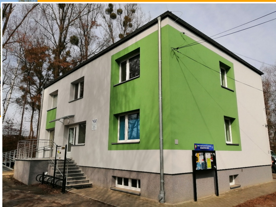
Ośrodek Zdrowia w Bełku po termomodernizacji
