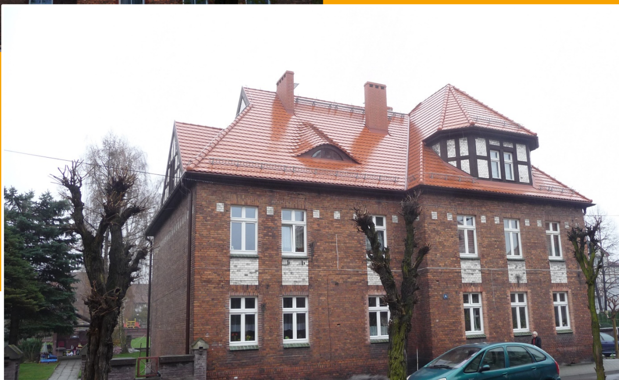
Budynek ul. Hallera 4 po modernizacji dachu
