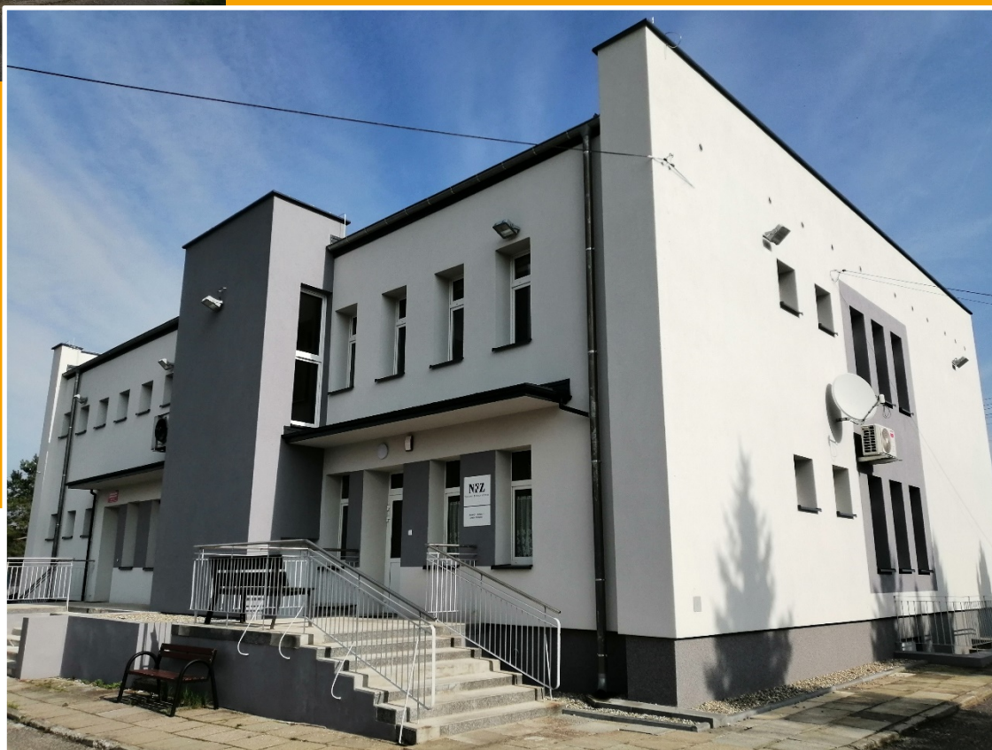
Ośrodek Zdrowia w Palowicach po termomodernizacji
