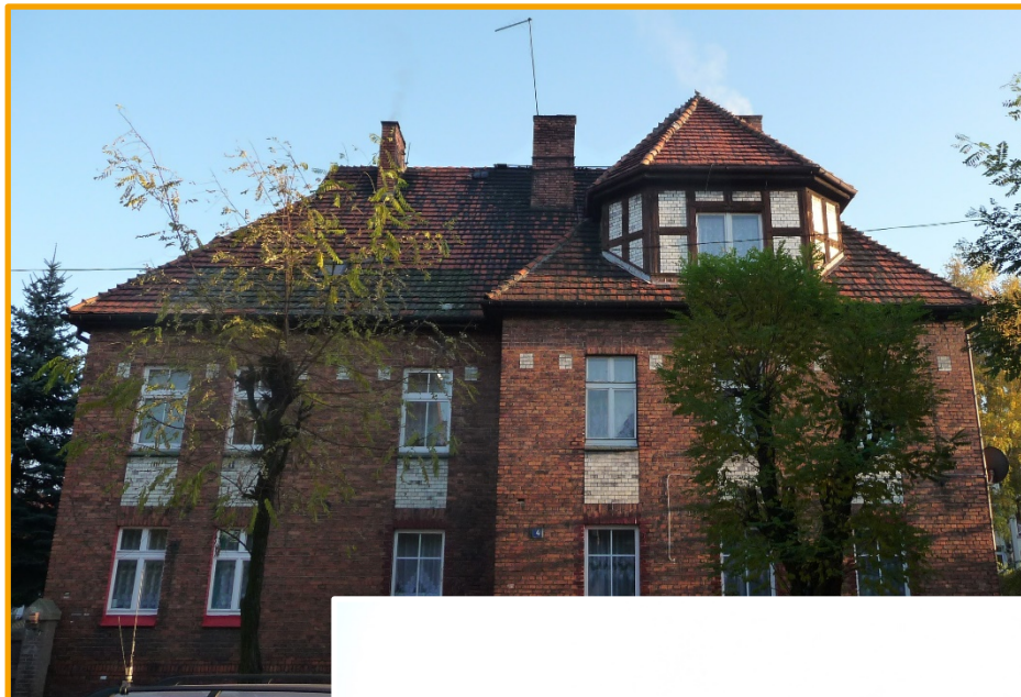
Budynek ul. Hallera 4 przed modernizacją dachu
