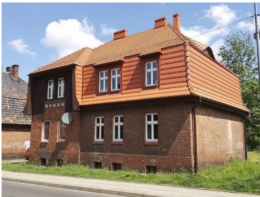
Budynek przy ul. Wolności 7 w Czerwionce-Leszczynach
