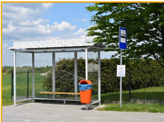
Wiata przystankowa w Szczekowicach przy ul. Palowickiej
